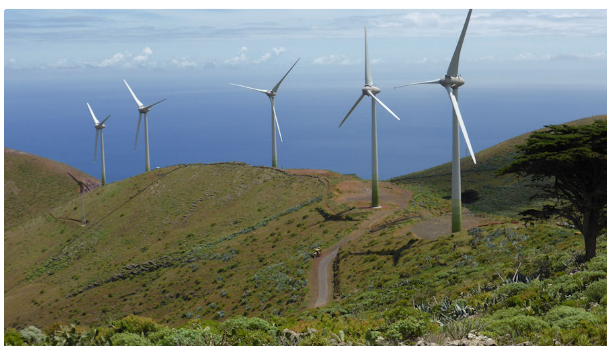
Parc éolien de El Hierro aux Canaries en Espagne
